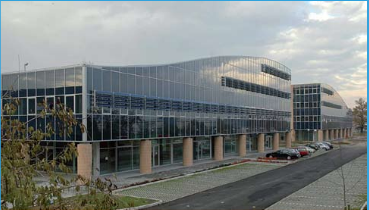
Faenza. Centro direzionale in bioarchitettura: facciata. (arch. P. Pagani).
