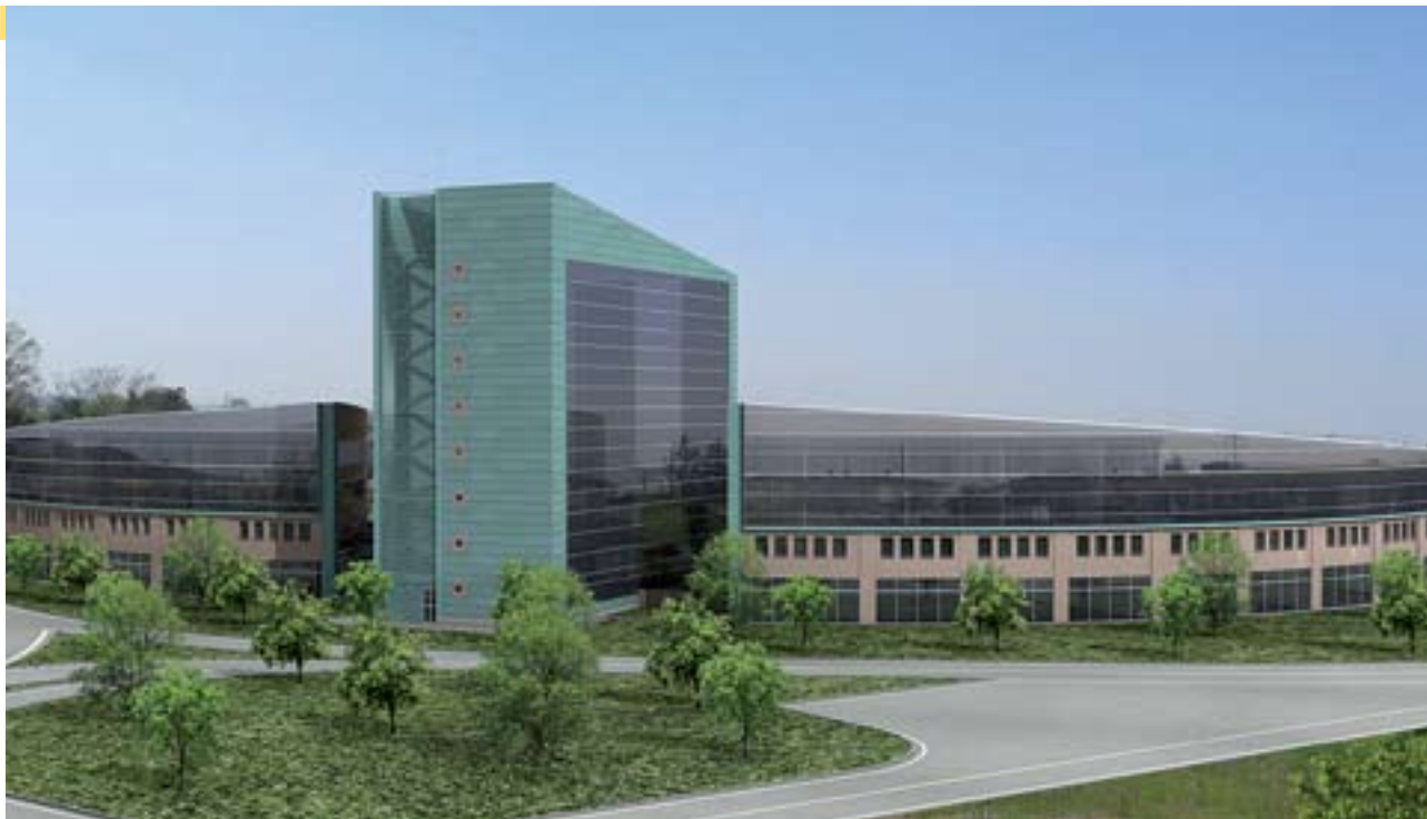
Faenza: albergo e centro plurifunzionale in bioarchitettura (arch. P. Pagani).
