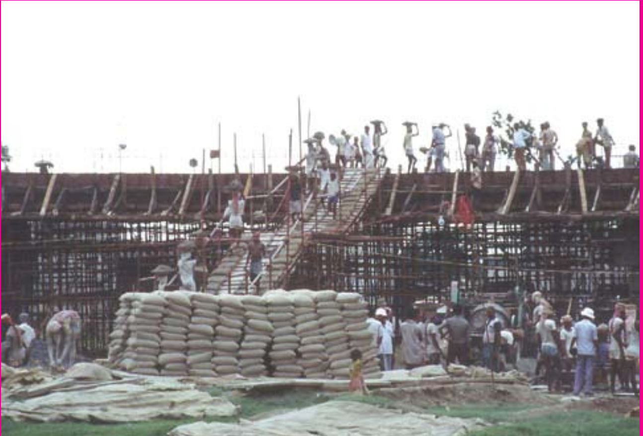
1983: grande cantiere edile a Calcutta.
