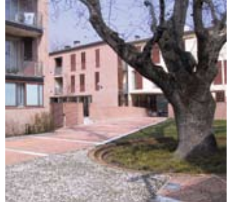
VIA CIMATTI ▷ (Arch. A. Bucci).
